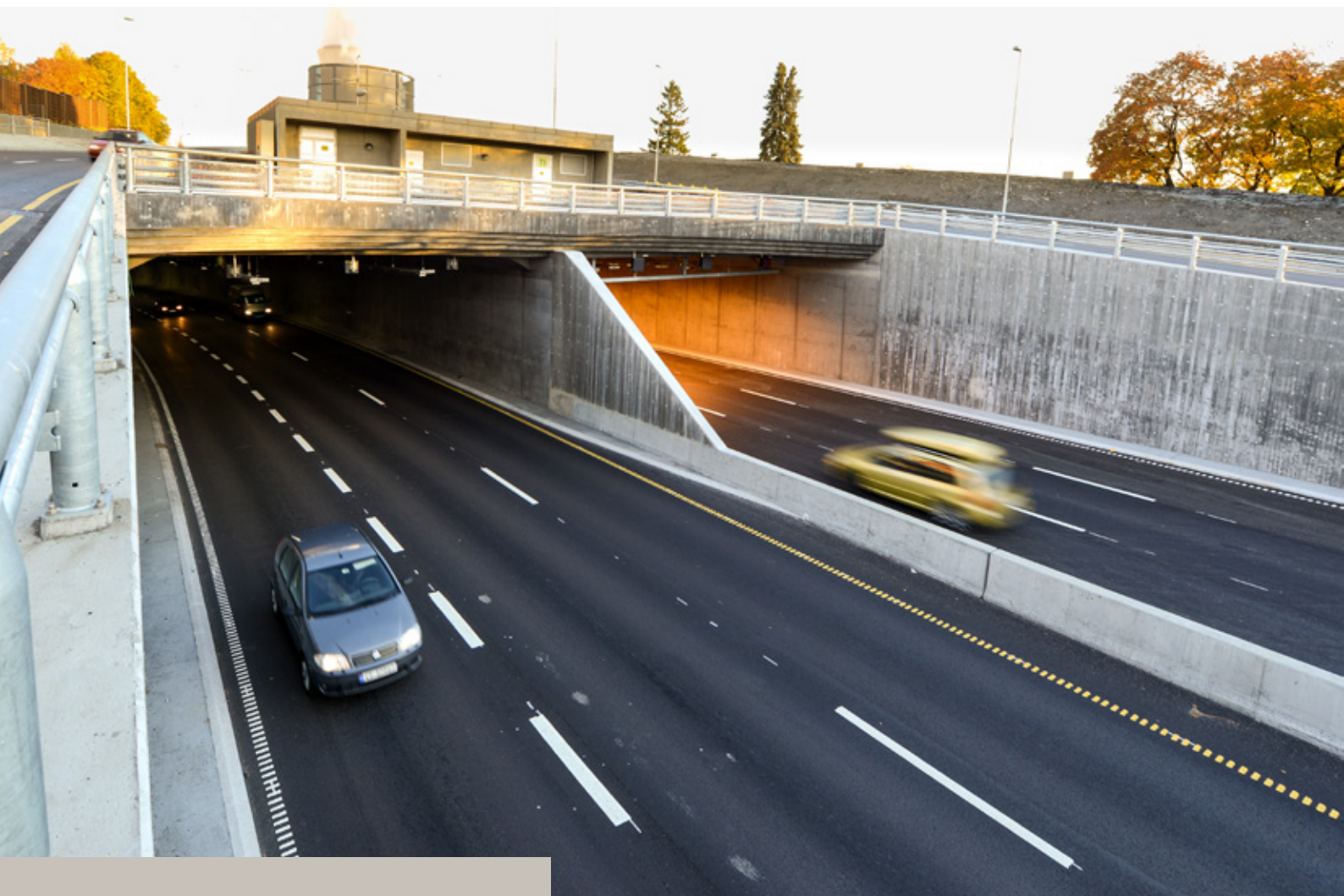
Lørentunnelen, Rv 150. Foto: Knut Opeide
