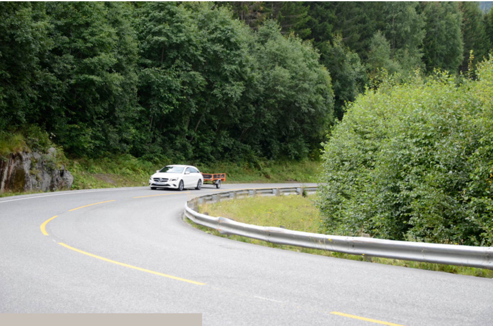
Riksveg 9, Telemark. Foto: Yngve Knausgård
