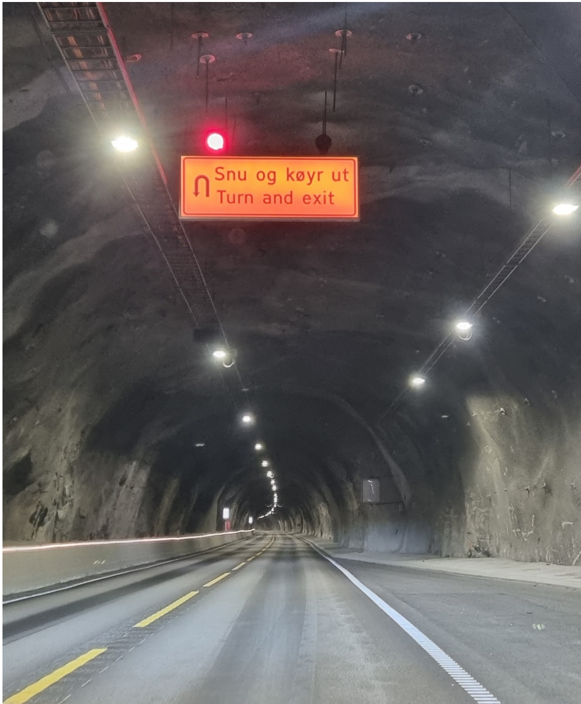
Bilete 2: E. 16, Voss/Aurland, testing av variable skilt og raudt stopplinksignal
