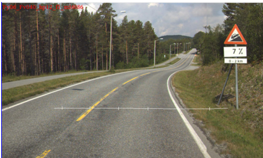
Bilde 1: Viser starten på ein bratt stigning på Fv40. Dette kan vera eit svakt punkt som kan bli vanskeleg å trafikkere på vinterstid.
