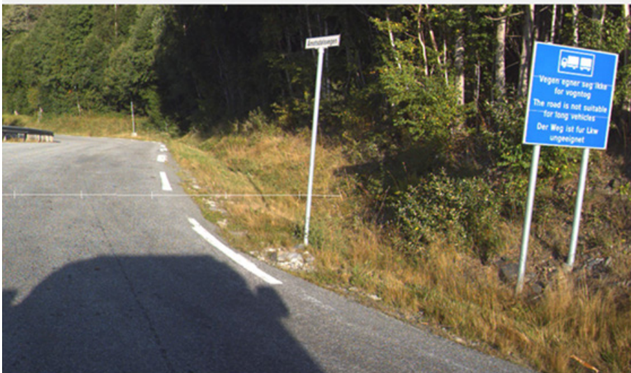
Bilde 3: Bilde viser starten på Fv503, som er omkøyringsveg for Ev134. Skiltet sier at «Vegen egner seg ikke for vogntog». Ifølge veglista kan vogntog på 19,5 meter køyre på vegen.
