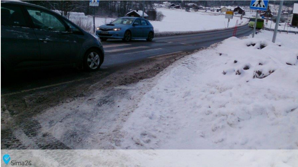
Manglande brøyting av gangfelt. Gående må ut i vegen eller klatre over snøhaug for å komme til gangfelt.
