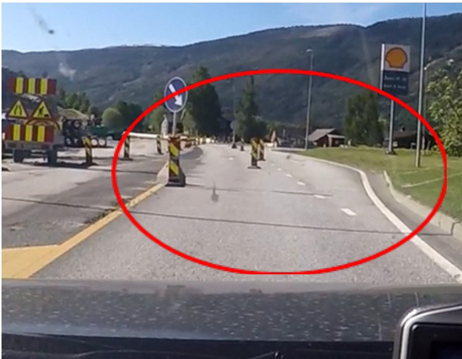
Bilde nr 2: Eksempel på mangelfull optisk ledning (arbeidsområde 2, E6 Sjoa x Fv 257).
