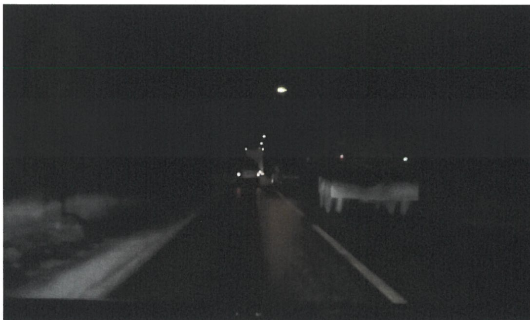
Gudvangatunnelen: Gravemaskin uten gulblink og med svake lys. Ingen markering eller sikring i forkant av maskinen. Tunnelen var på dette tidspunktet kolonnekjørt.
