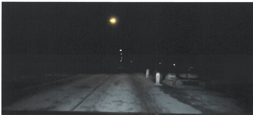
Gudvangatunnelen: Bildet viser manglende markering og sikring av maskin som står i nisjen, uvaskede kantmarkører (skilt nr. 906) og manglende veimerking. Fartsgrensen på stedet er 70 km/t.
