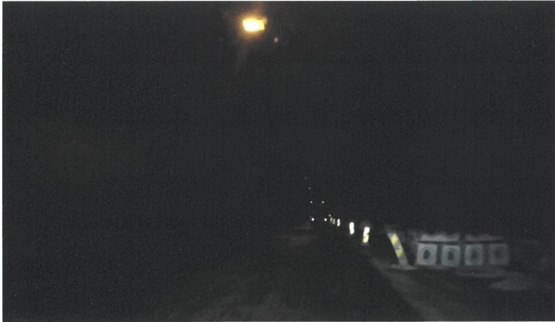
Gudvangatunnelen: Bildet viser en nisje der det er lagret betongfundamenter helt inntil vegkanten, uten sikring. Fartsgrensen på stedet var 70 km/t.
