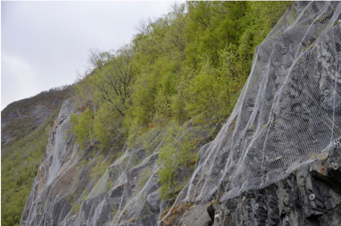
Biletet syner vegetasjon i nett. Under inspeksjon fann Vegtilsynet at om lag 41 prosent av netta på dei undersøkte strekningane hadde vegetasjon.
