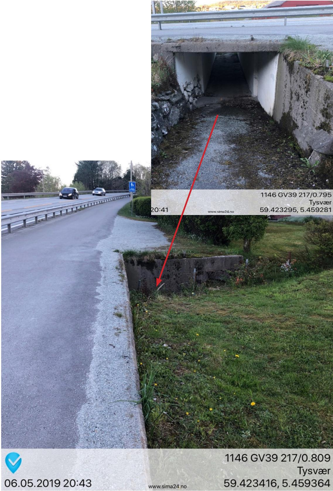
Bildet viser skada gjerde før undergang, der berre restane av innfestinga står igjen. Fall fra gang- og sykkelveg og ned i undergang er om lag to meter. Tilstand var ikke i samsvar med krav til Kap. 5.17 Gjerde.
