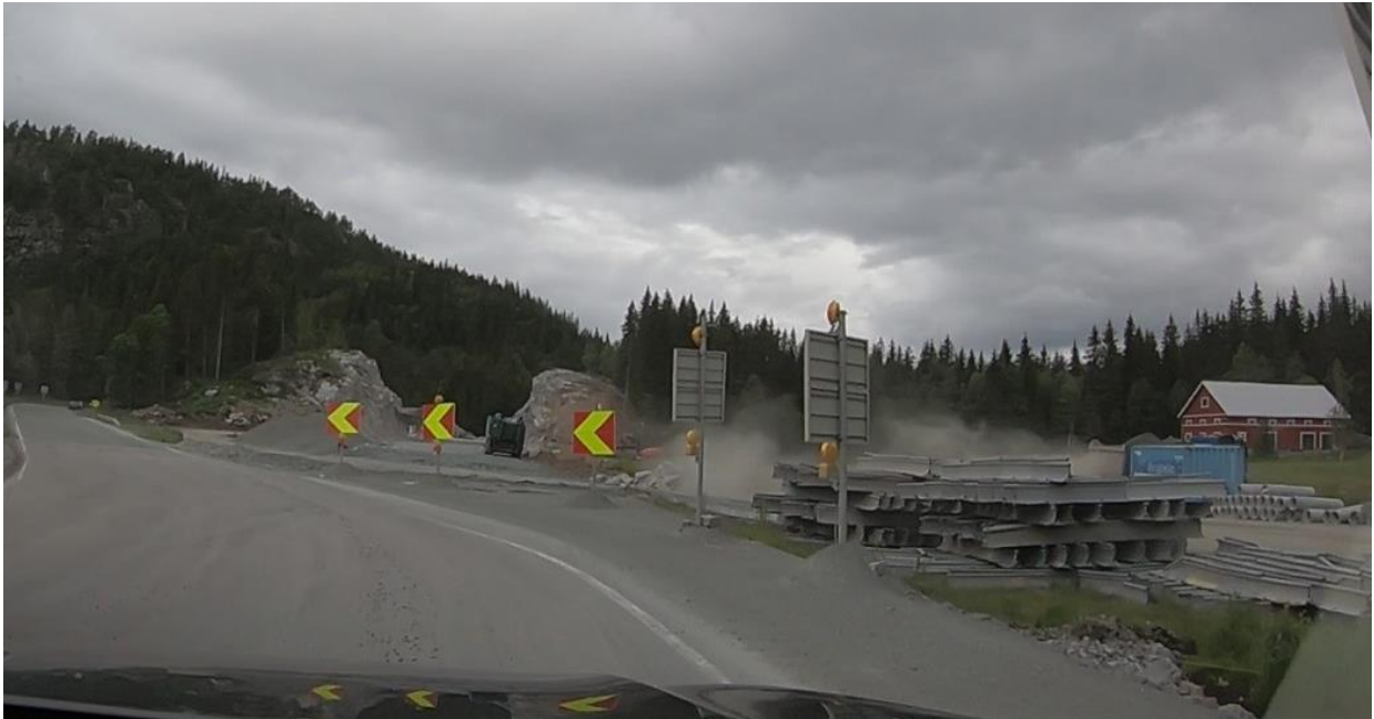
Påkjørselsfarlige element i sikkerhetssonen, rekkverkelement (E134 Åmot- Seljord)
